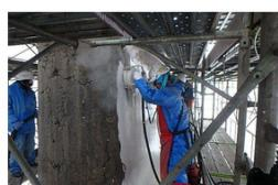
ウォータージェット（water jet）とは高圧力まで加圧された水を先端に設置した微細なノズル（オリフィス）から吐出し得られる細い水流のことです。圧力は245MPaにもなります。
